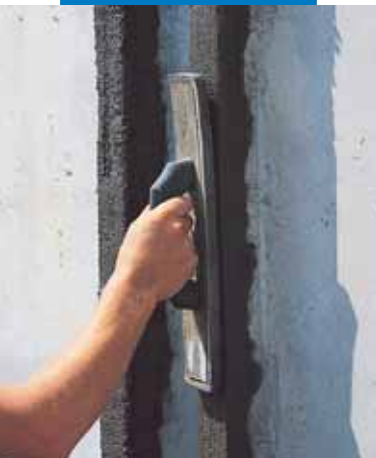
Dokončení pryžovým hladítkem
