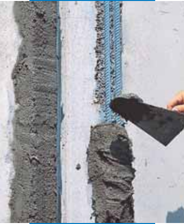
Nanášení zednickou lžící
