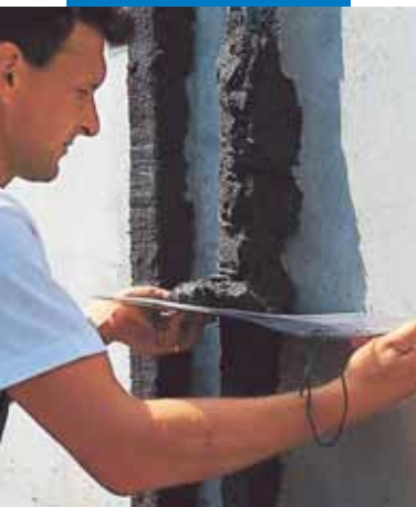
Odstranění přebytečné malty
