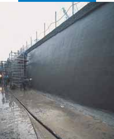
hydroelektrický kanál Bertini - Robbiate (Como) - Itálie: celkový pohled
