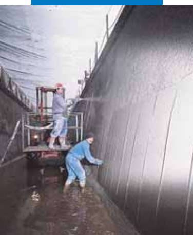
hydroelektrický kanál Bertini - Robbiate (Como) - Itálie: povrchová úprava hladítkem
